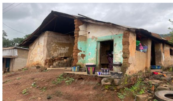
Figure 1 ; Maison détruite lors de travaux routiers, avec indemnisation non adéquate (AMG 2026)
